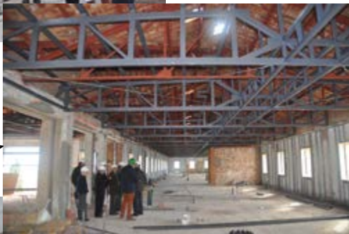
Nuevas cerchas para instalaciones en el bajo cubierta
